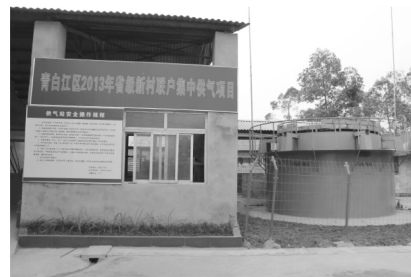
图 2 湿式储气柜及管理房
