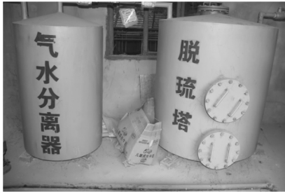
图5 脱硫脱水装置
