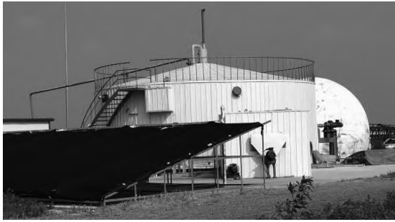
图 15 300 m 3 沼气示范工程
