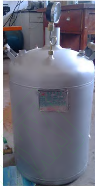
图 6 直接换热式热水加热器
