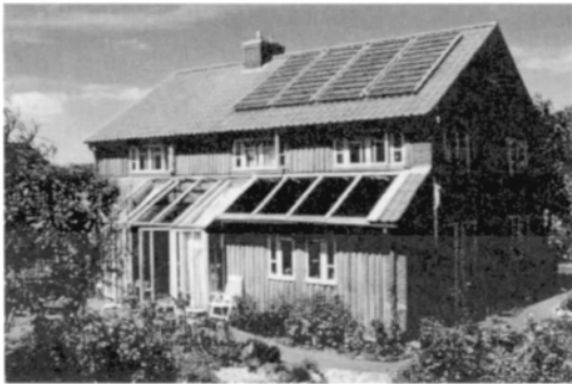
图2 主、被动式相结合的太阳房
