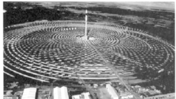
图3 太阳能高塔电站全景
